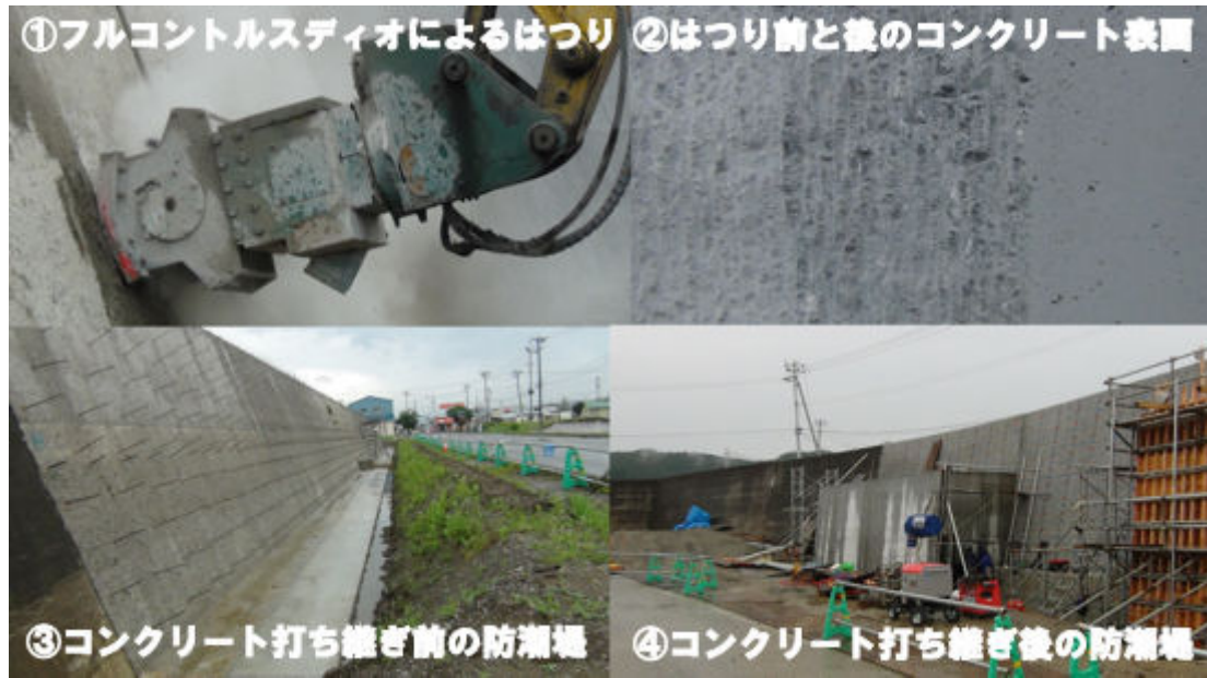
フルコントロールスタジオのはつり作業から打ち継ぎ後まで
