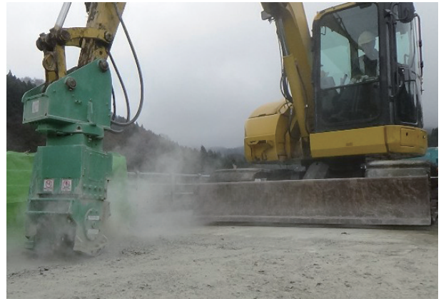
合成床版のコンクリート舗装切削状況（山形県）
