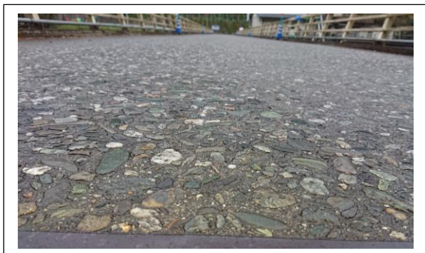
50年前に作られたコンクリート橋
